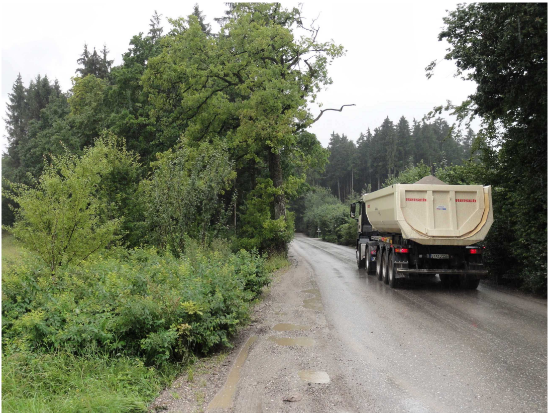
Abb. 1 Weißlinger Straße bei ca. Bau-km 1+530 – geplanter, durch Schwerlastverkehr stark vorbelasteter Ausbauabschnitt der Westumgehung im Wald
